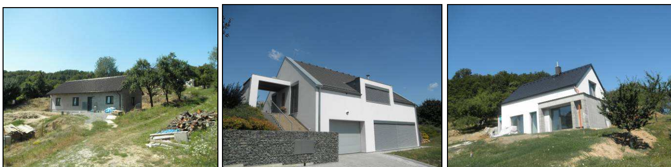
Příklady novostaveb respektujících venkovský charakter zástavby - vlevo tradiční řešení, uprostřed a vpravo se soudobými stavebními prvky
