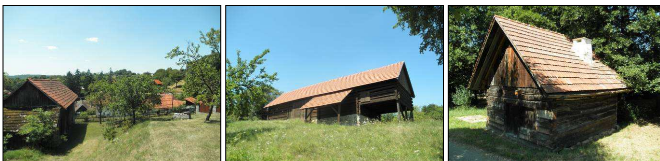
Příklady historických staveb: vlevo původní zástavba na S okraji historické silniční vsi, uprostřed rekonstruovaná, roubená stodola za OÚ, vpravo roubená polní kovárna v části Mlýny
