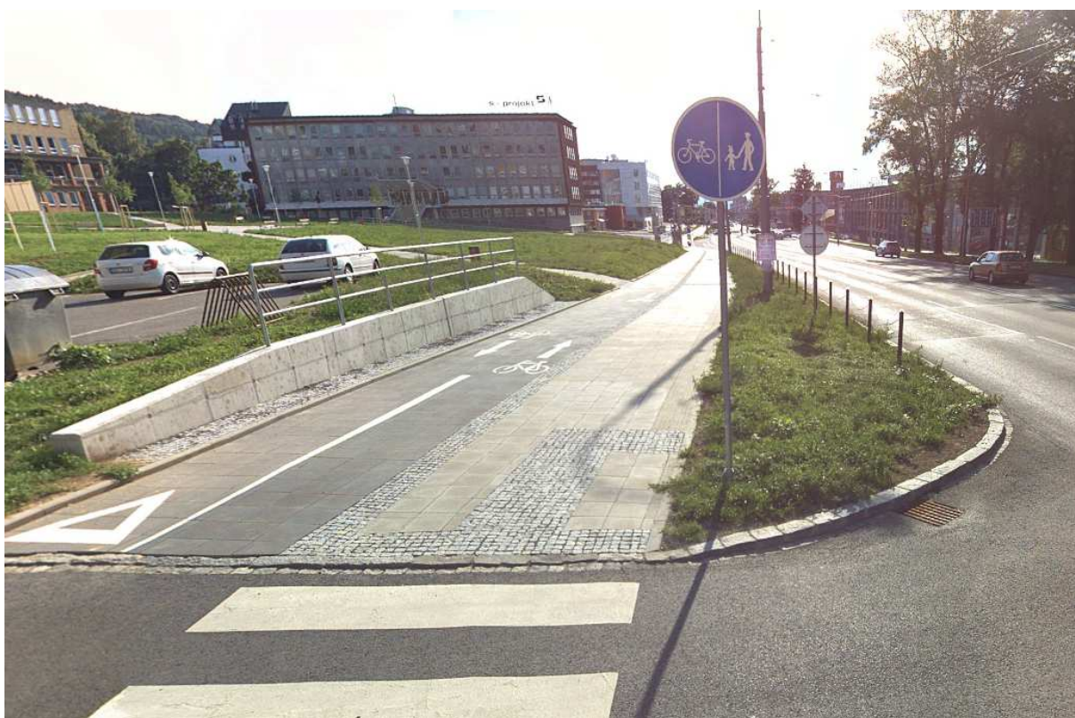
Obrázek 24: Praktický příklad správného uspořádání stezky pro chodce a cyklisty s odděleným provozem, Zlín-stezka podél ulice třída T. Bati
