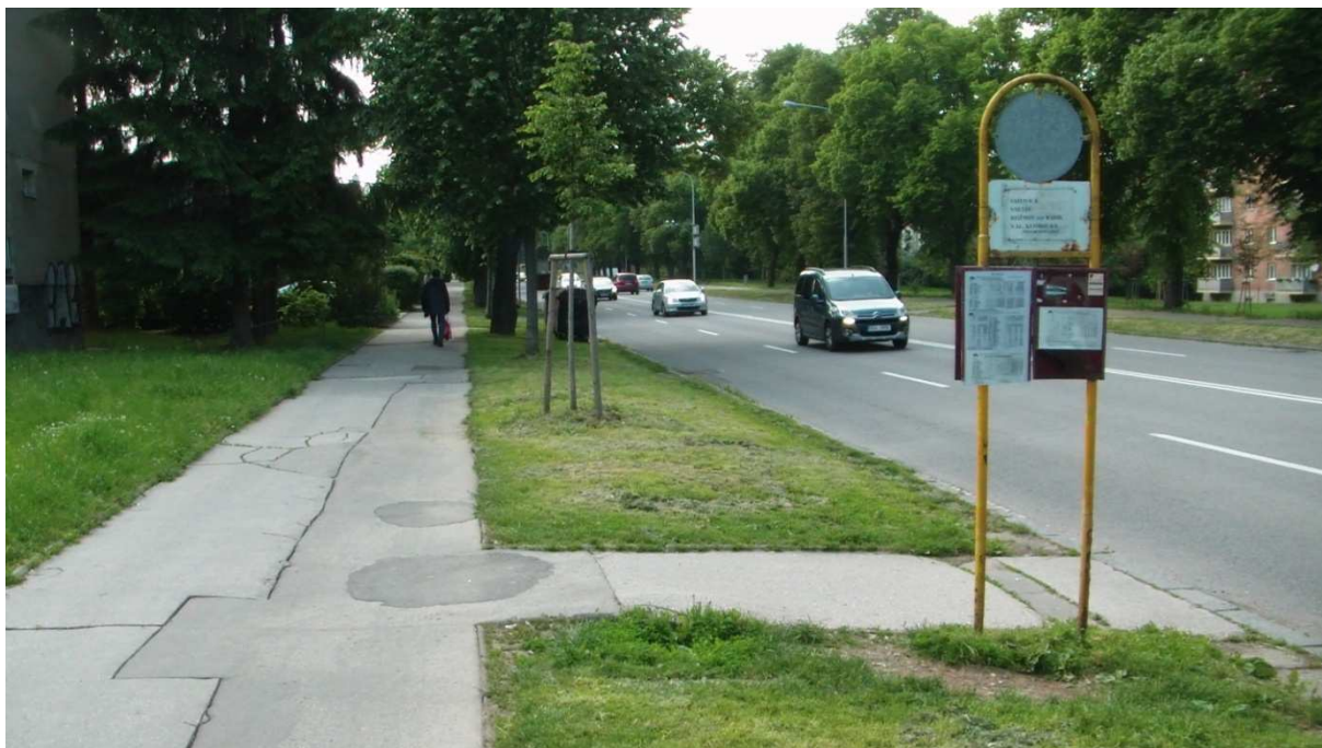
Obrázek 23: Nevýhovující stavební stav zastávky VHD Věžové domy
