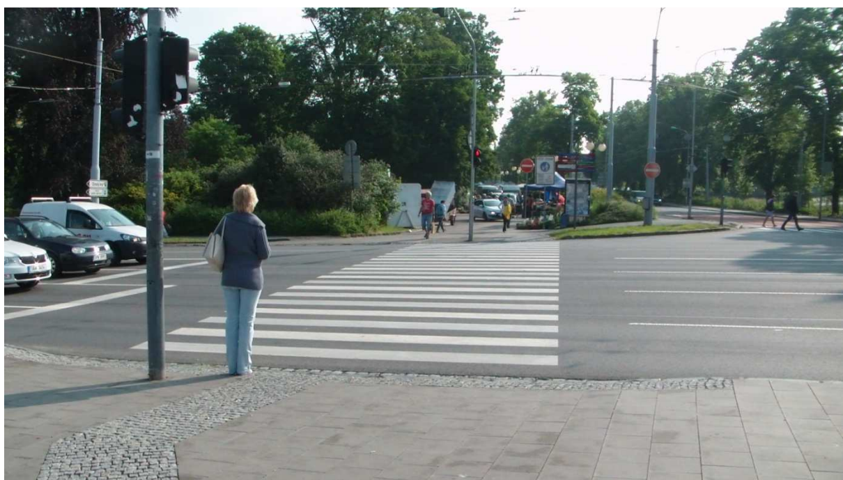
Obrázek 14: Nevyhovující délka přechodu řízeného SSZ (cca 21 m) přes ulici Gahurova
