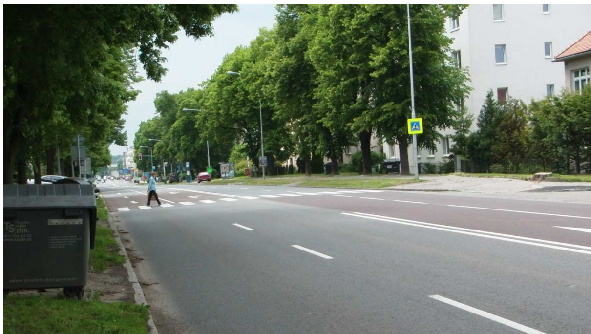
Obrázek 17: Nevyhovující délka přechodu neřízeného SSZ (cca 13 m) přes ulici třída T. Bati, nesnížená obruba, chybějí prvky
