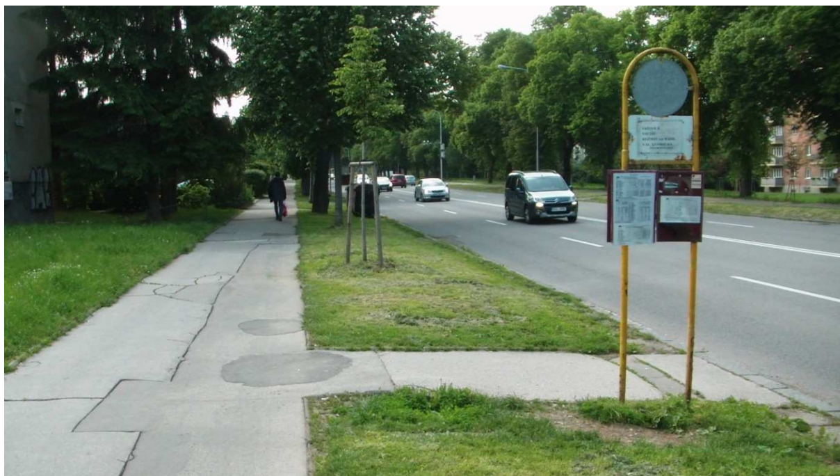
Obrázek 19: Nevyhovující stavební stav zastávky VHD Věžové domy
