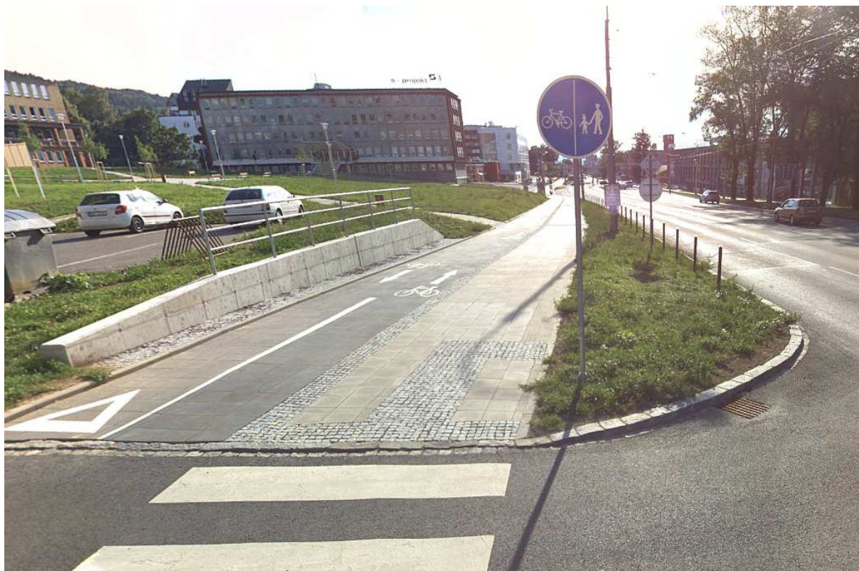
Obrázek 20: Praktický příklad správného uspořádání stezky pro chodce a cyklisty s odděleným provozem, Zlín-stezka podél ulice třída T. Bati
