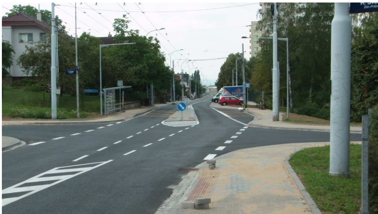
Obrázek 11: Neúplnost prvků v místech pro přecházení na ulici Mostní (komunikace po rekonstrukci)
