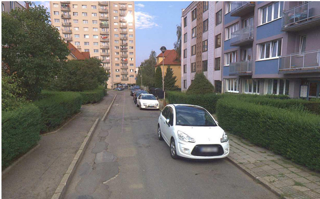
Obrázek 22: Stávající dopravní situace na ulici Ševcovská k domu 4078
