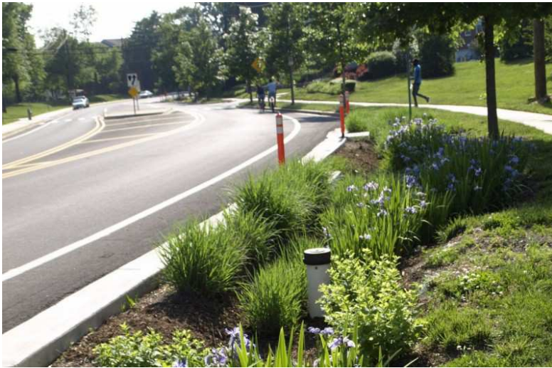
Zasakovací pás (průlehy) zadržující vodu v území
