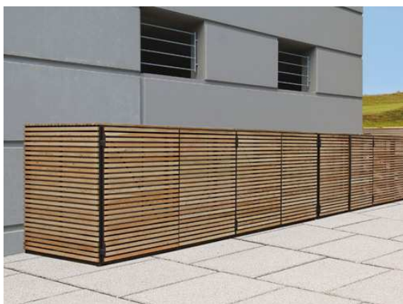
Dřevěný paraván na kontejnery na kovové konstrukci. Odclonění nevzhledného odpadu u hřbitova Provedení kamenných zídek v parku u hřbitova z bezespárového kamenného zdiva
